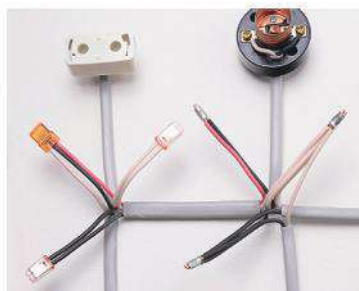
(画像2) 技能試験での完成回路例
