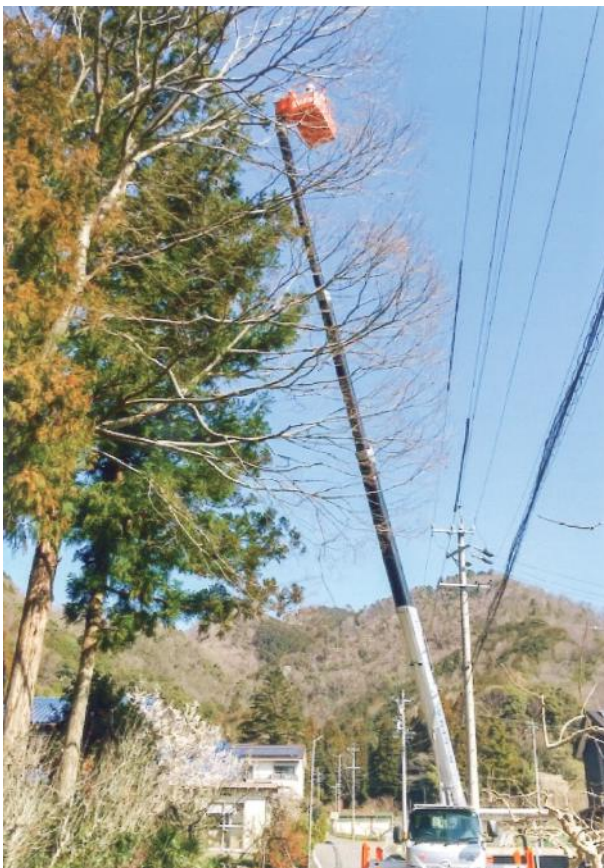
高所作業車作業
